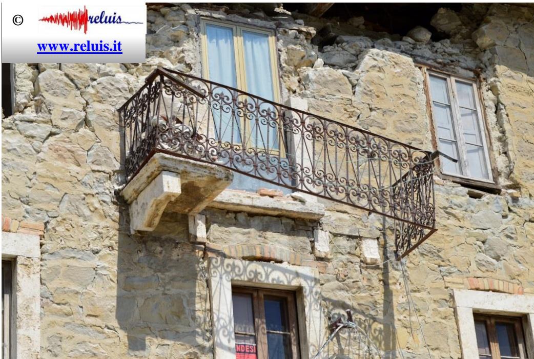
Edificio in muratura – Pescara del Tronto (frazione di Arquata del Tronto) Crisi nel piano dei pannelli murari e crisi delle travi di supporto (gattoni) di un balcone.
