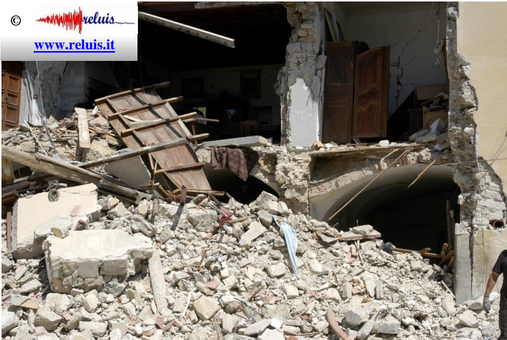
Edificio in muratura - Amatrice Collasso di pareti, pilastri e volte in muratura.
