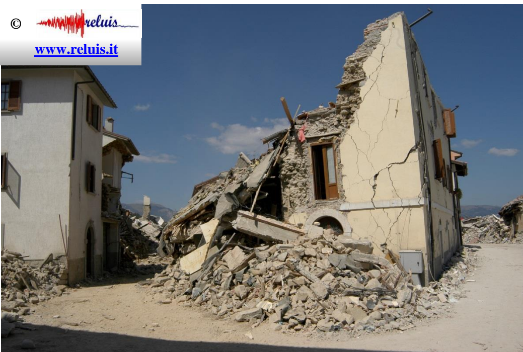
Edificio in muratura - Amatrice Crollo parziale dell'edificio.
