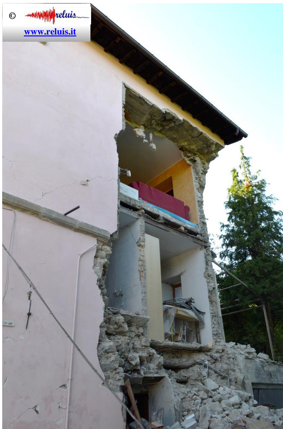
Edificio in muratura - Accumoli Meccanismo di crisi per disgregazione e ribaltamento fuori piano.
