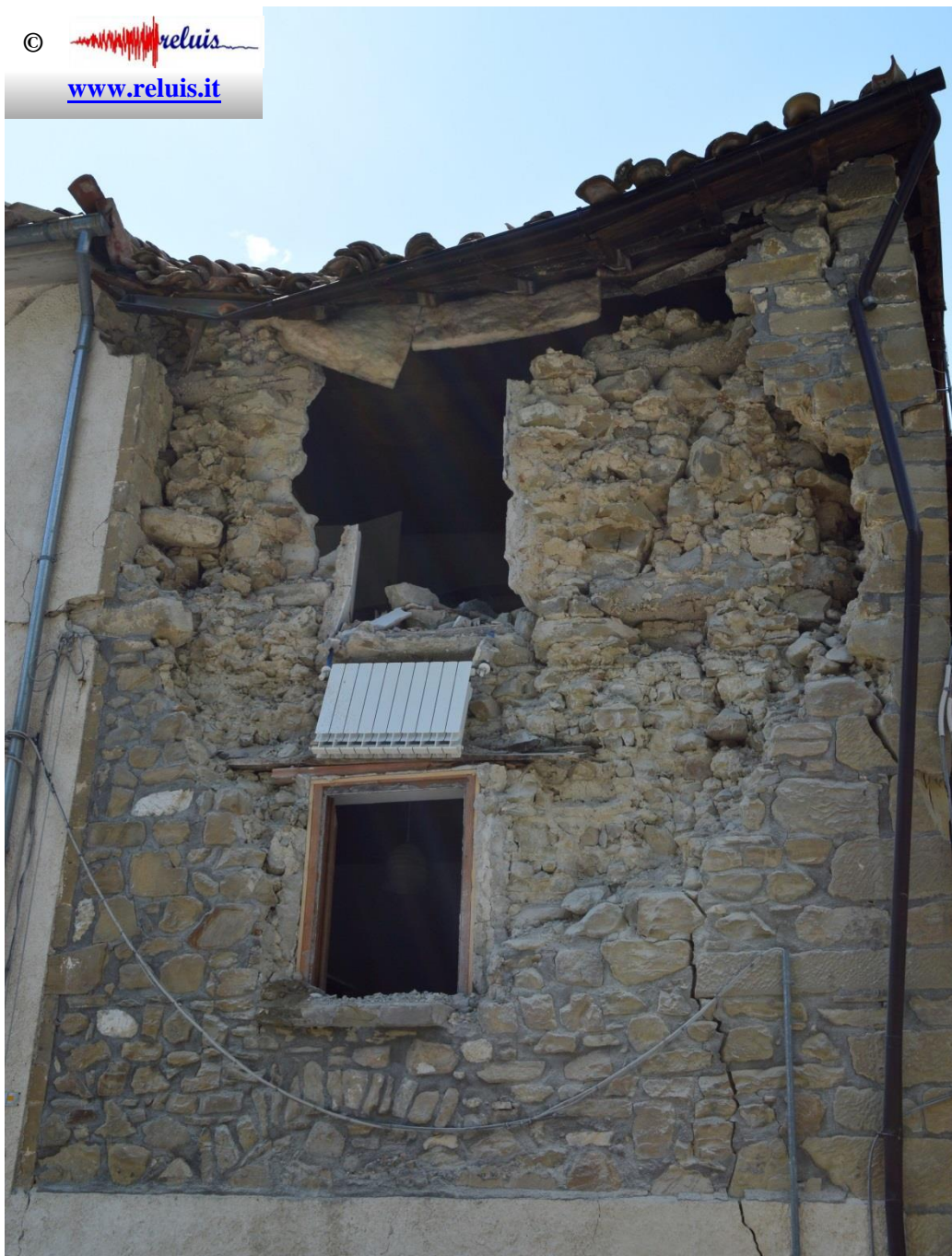
Edificio in muratura – Pescara del Tronto (frazione di Arquata del Tronto) Evidenza di crollo del paramento esterno della muratura a doppio paramento.
